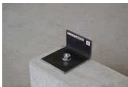
④施工後、プッシュナットを外し、座付きナットをセット
