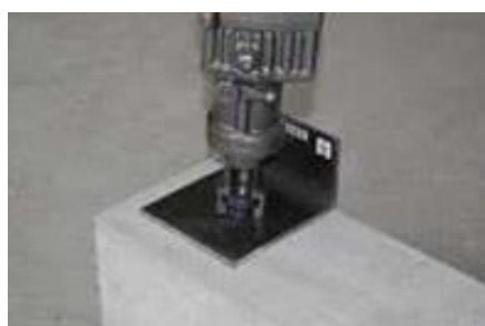
③オールアンカーを施工する穴に挿入して施工する
