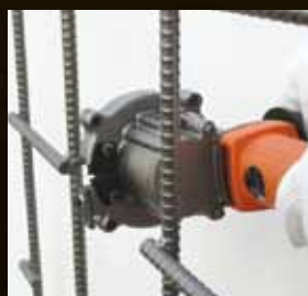
開口部をツラで切断
