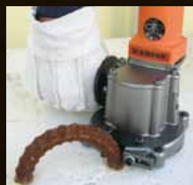
不要な鉄筋をツラで切断
