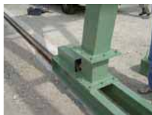
■レール敷設例
